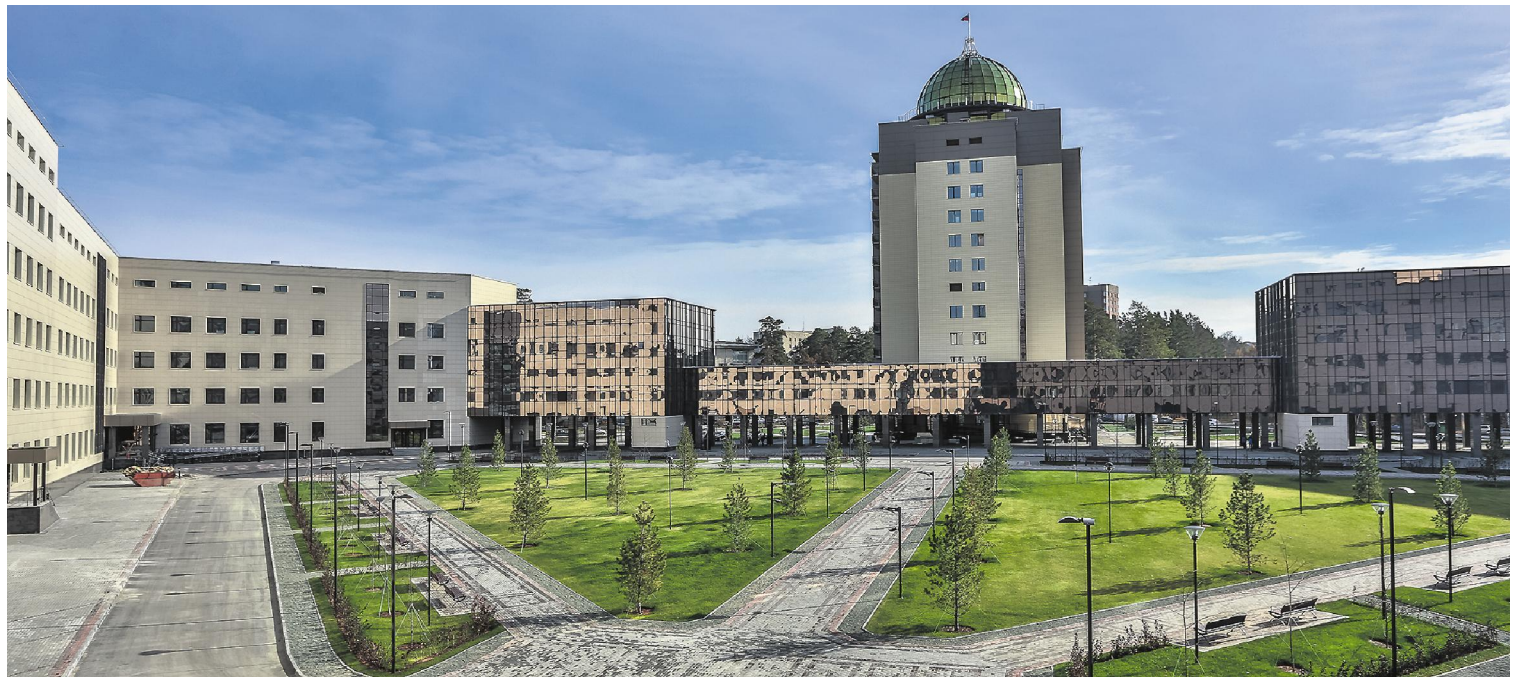
Новый корпус НГУ состоит из пятиэтажного учебного корпуса в 45 тысяч кв. м и 12-этажной административной высотки на 10 тысяч кв. м.
