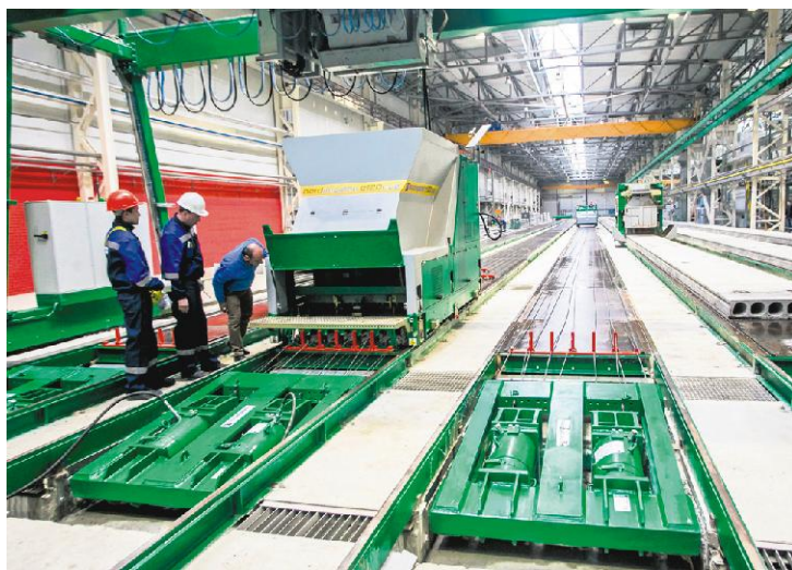
Завод «Арматон» начал работать с февраля 2015 г.
