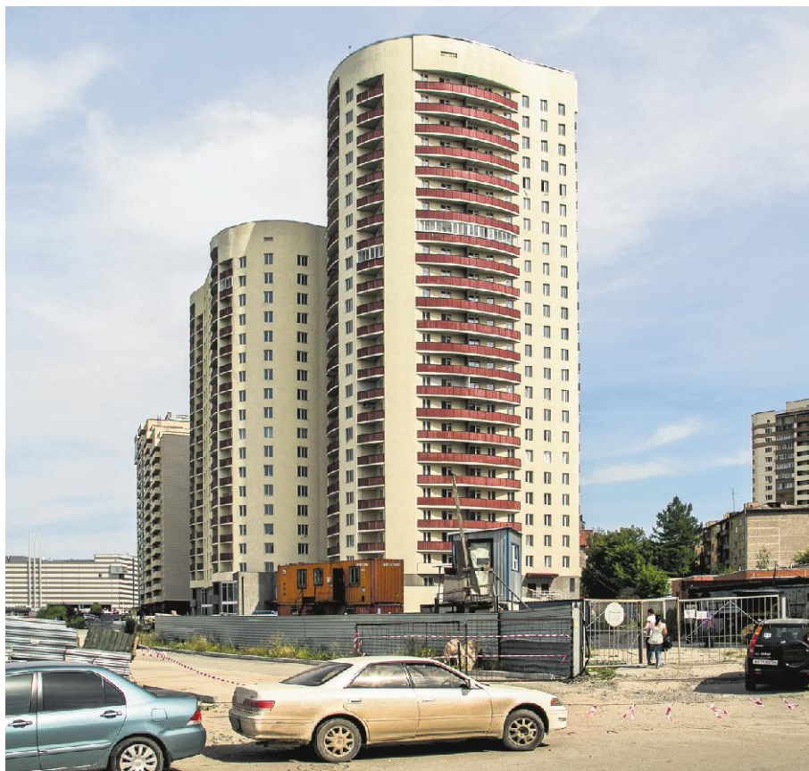
18—24-этажный дом на ул. Галушак, 15 начали строить в 2007 году. Его достройкой сейчас занимаются два созданных здесь ЖСК.
