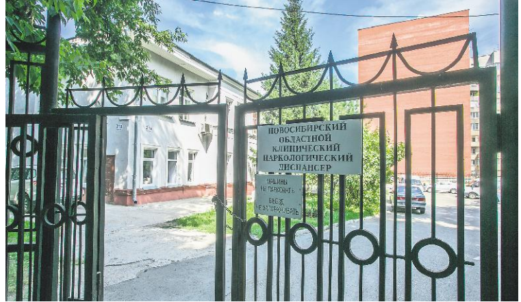
Произведён капитальный ремонт зданий областного наркологического диспансера. Затраты составили 9,5 млн рублей.
