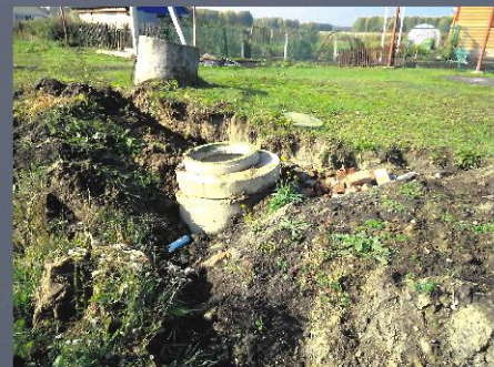
▶ п. Емельяновский: пазухи колодца заполнены строительным мусором.
