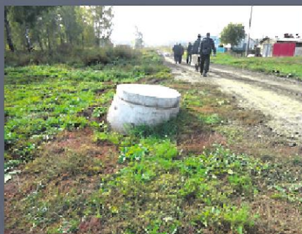
▶ п. Емельяновский: наклон колодца свидетельствует о нарушении технологии монтажа.
