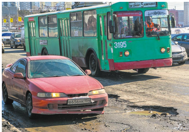
Как утверждают специалисты, больше всего повреждены дороги, где не проводился плановый ремонт.
