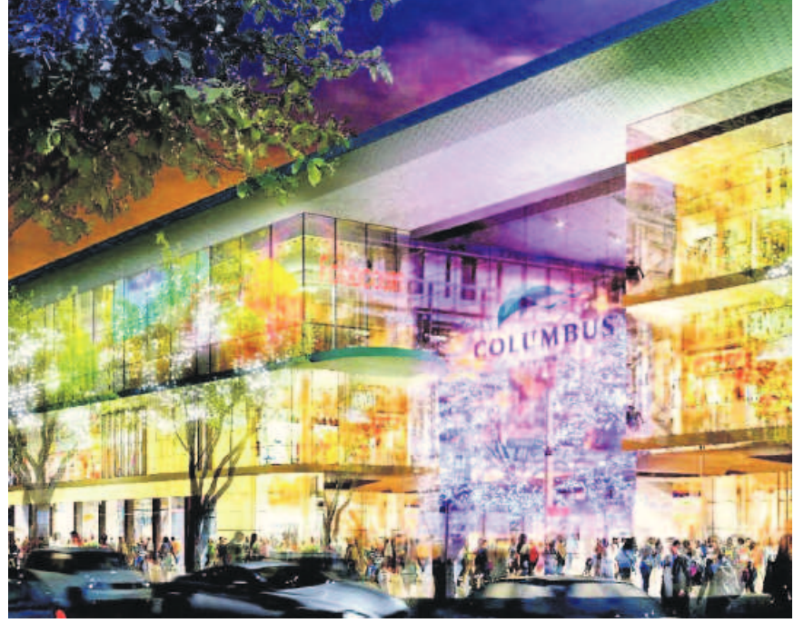
ТРЦ «Колумбус» (270 000 кв. м), г. Москва.
