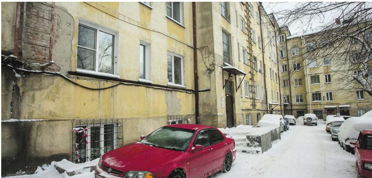
В этом году в Новосибирске должно быть капитально отремонтировано 899 домов. В том числе — на Серебренниковской, 9.
