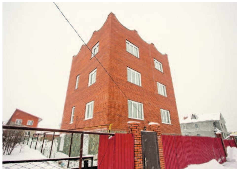
Дом без адреса на ул. Прокопьевской. Визуально отличить «благонадёжную» застройку частного сектора от незаконной часто невозможно.
