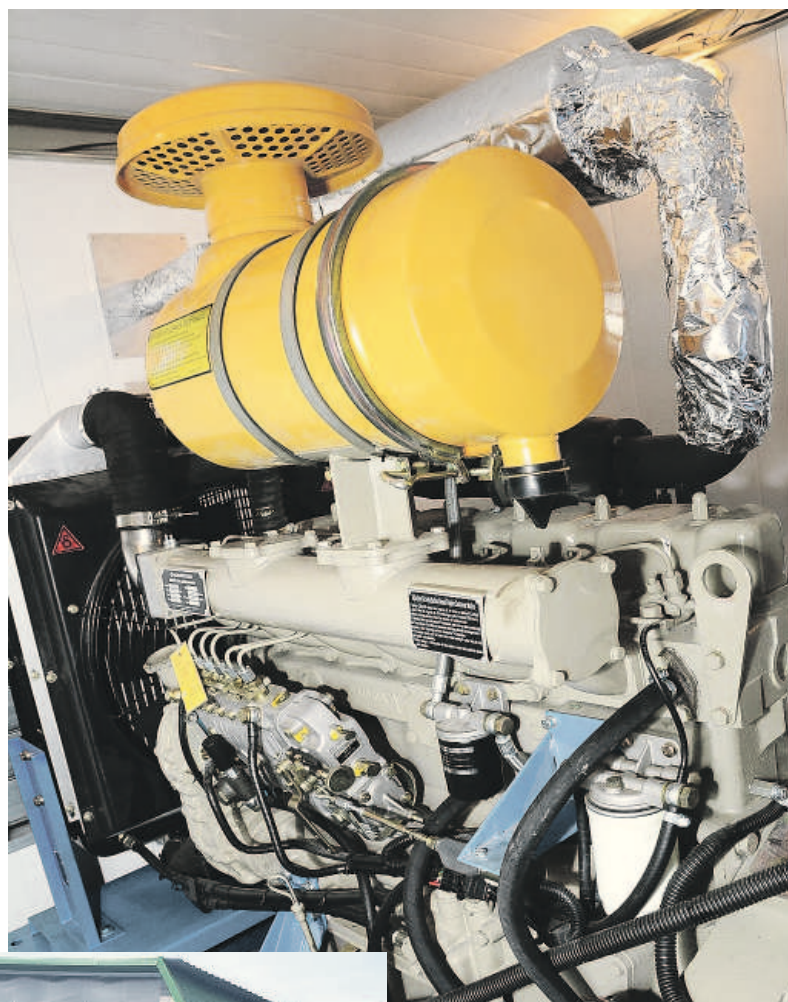
Одно из направлений работы «КомплектЭнергоСтроя» — поставка электростанций для промышленных предприятий.
