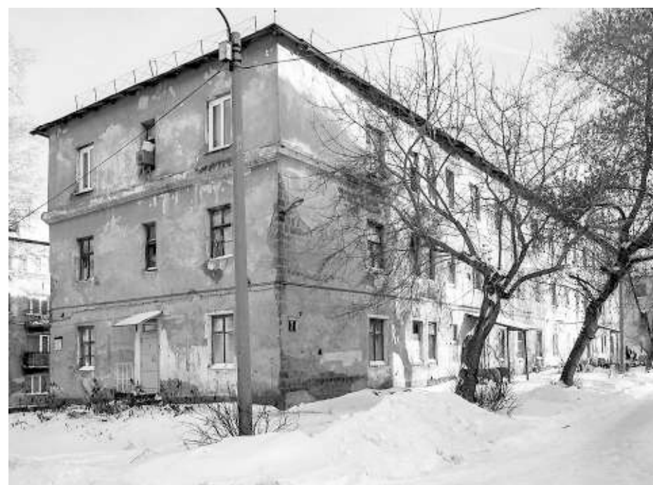
Дом на ул. Бурденко, 2 признан аварийным, и в ближайшем будущем его жильцы должны быть переселены.
