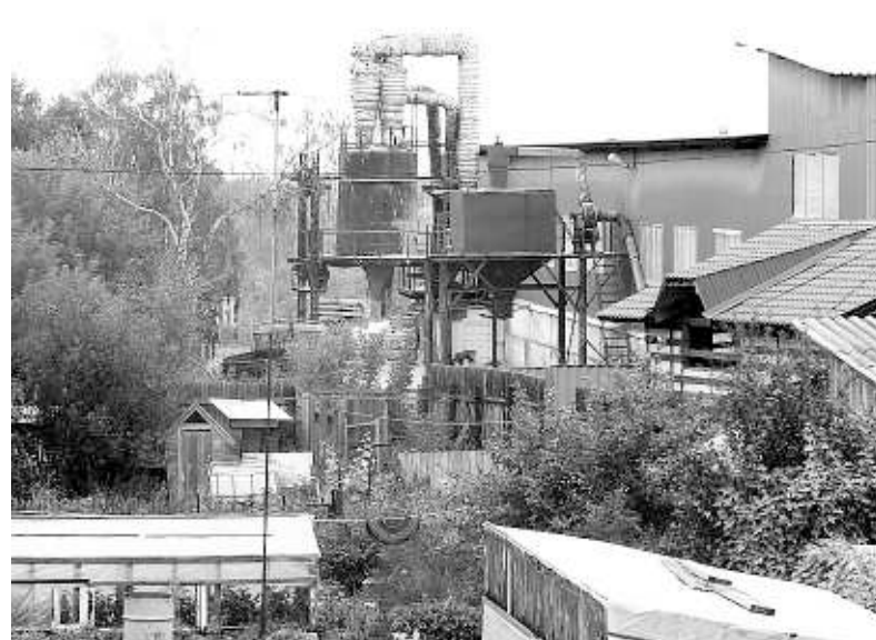
Промплощадка, которая, по мнению жителей дачного посёлка, загрязняет окружающую среду.
