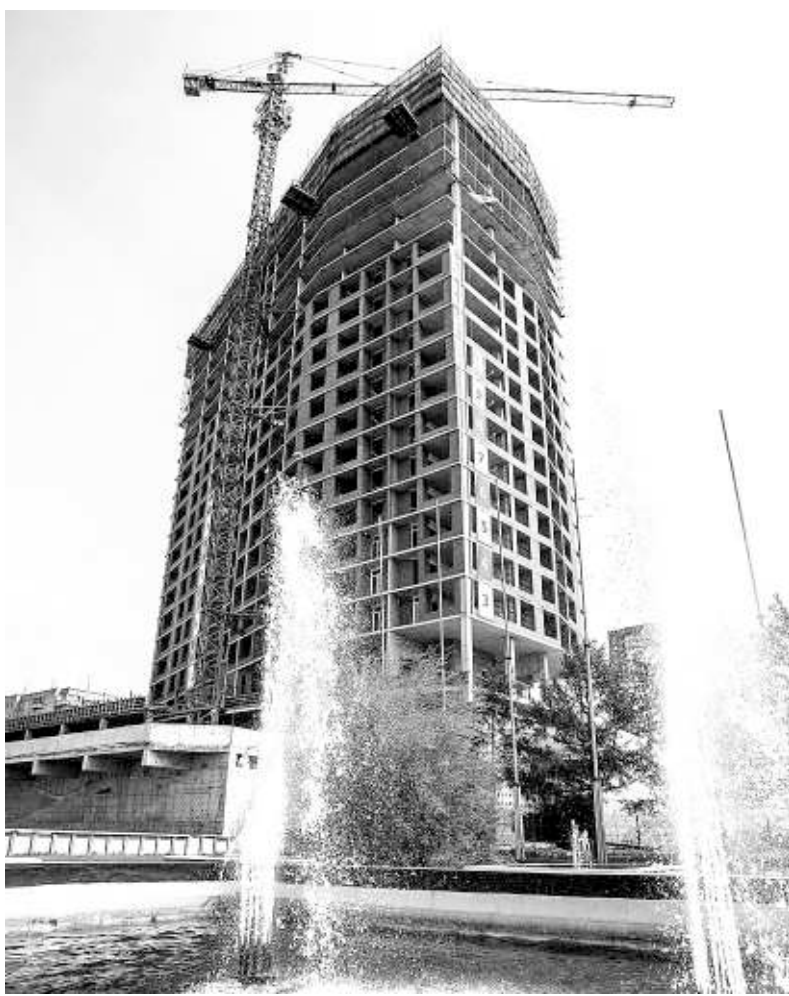
Жилищное строительство — драйвер экономики региона.
