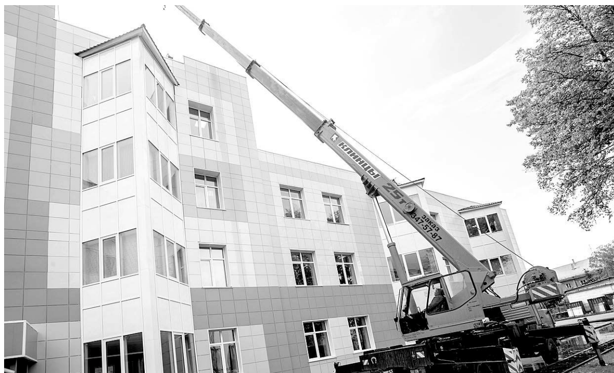
В 23-й школе ещё идут работы по установке прозрачного купола над внутренним двориком.
