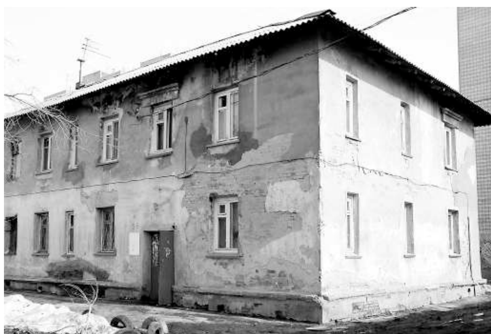
С 2004 года в Новосибирске было расселено и снесено около 260 ветхих и аварийных домов.
